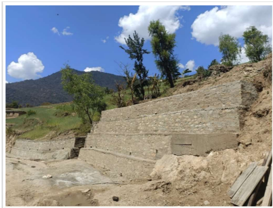
कोललाइन पर्खाल निर्माण कुशे ३
