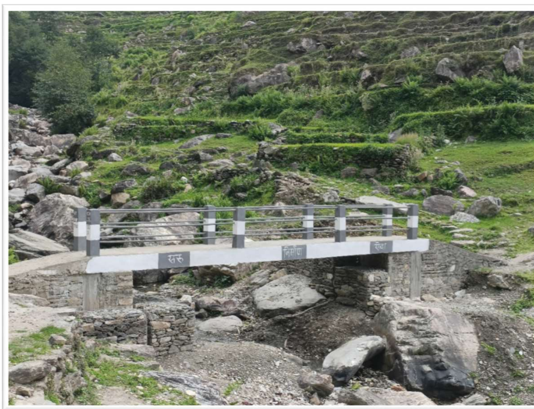
बलिघट्ट आर सि सि पुल निर्माण कुशे ९
