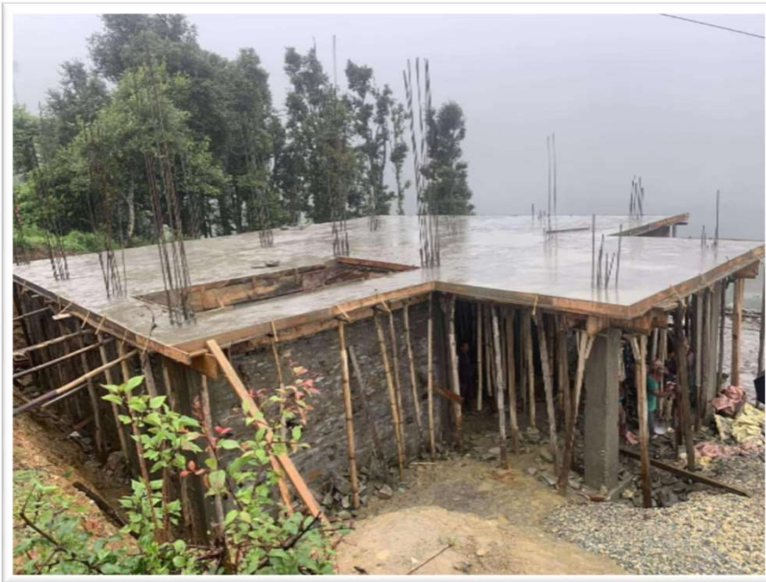
निर्माणाधिन वडा नं ५ को कार्यालय भवन
