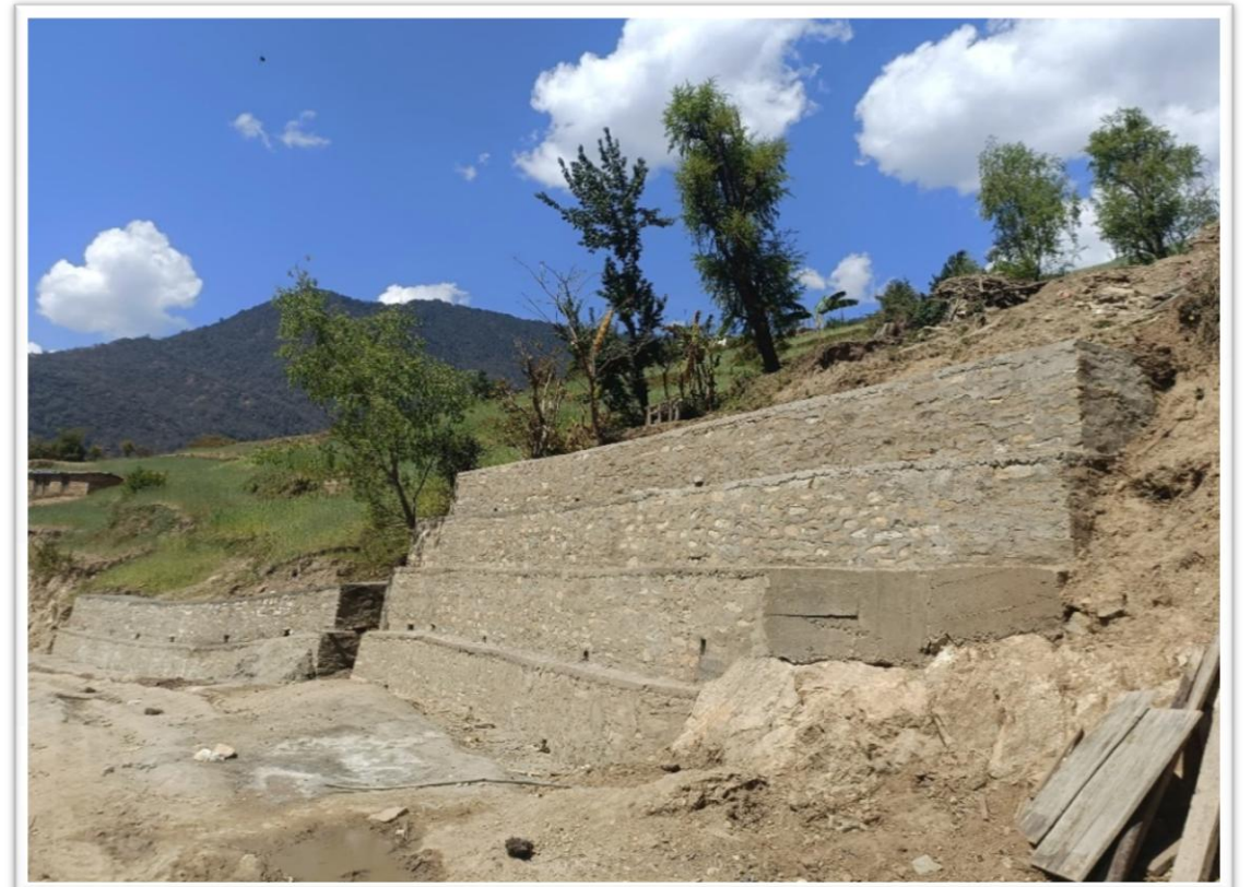
कोललाइन पखाल निर्माण कुशे ३
